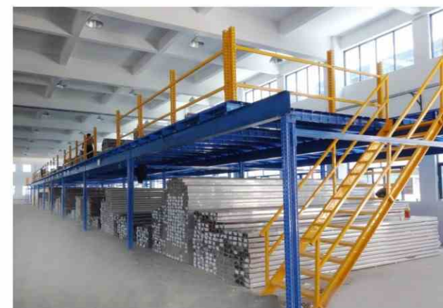
Steel structure & big span platform 钢结构大跨度平台
