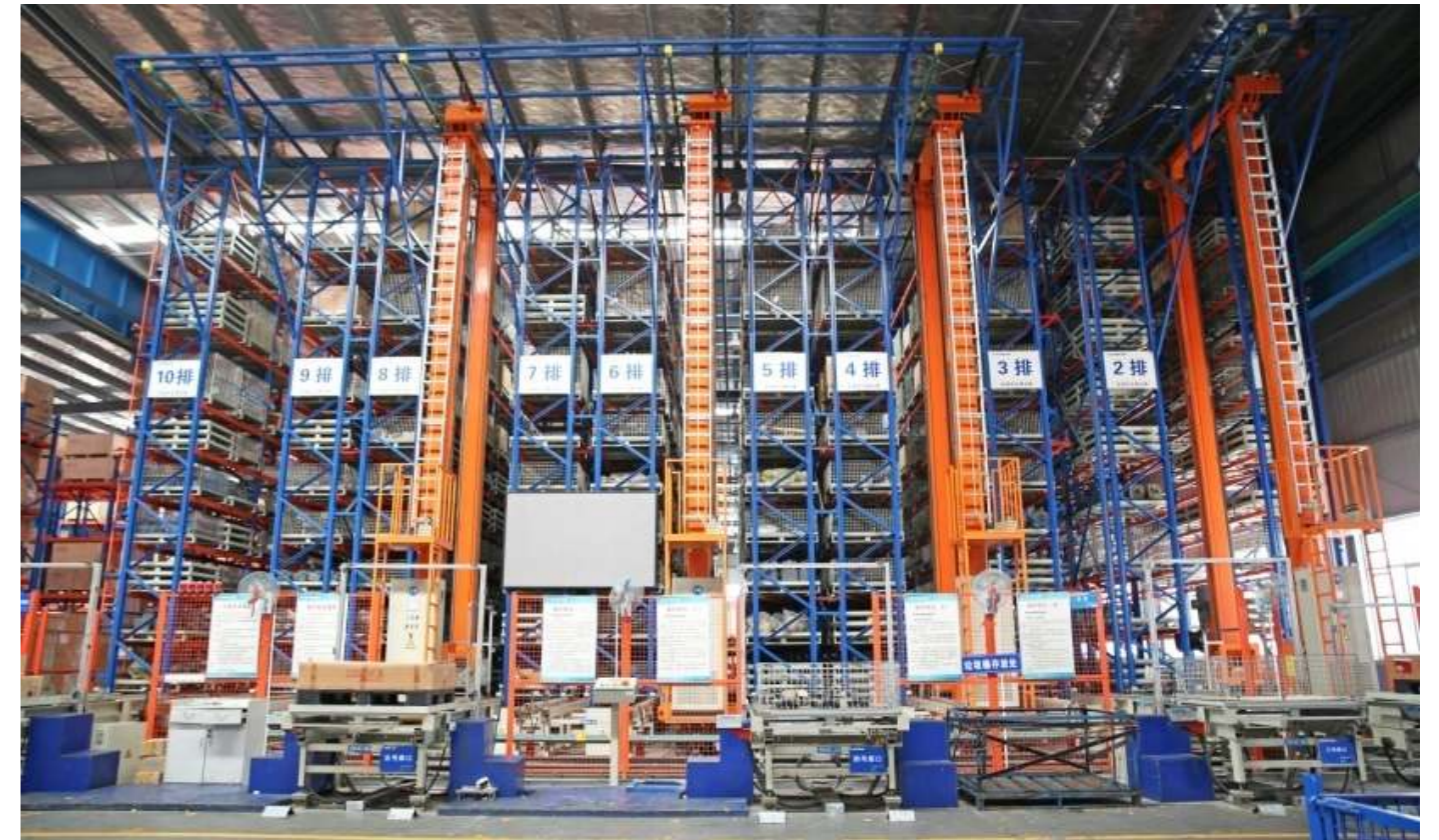
Automation warehouse AS/RS system 自动化立体仓库AS/RS系统
